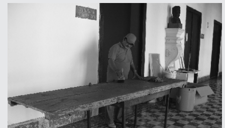
Reacondicionamiento del área que ocupa la Dirección de Posgrado.
